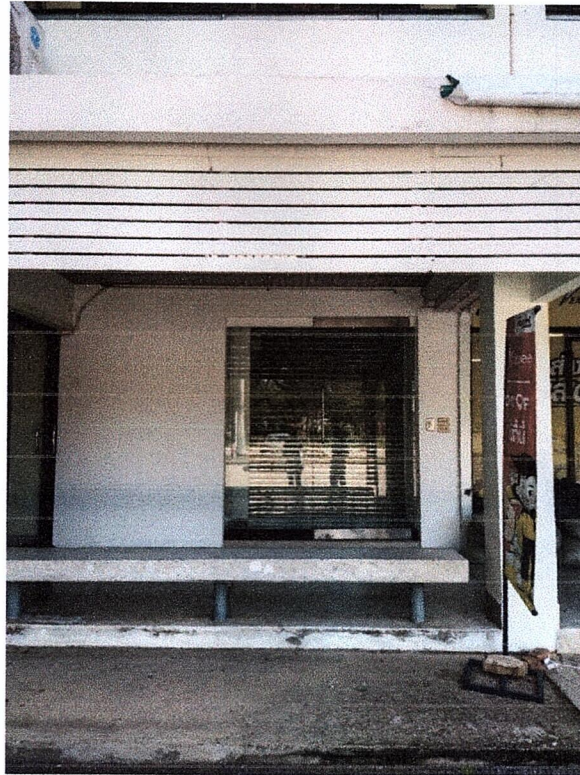
ร้านค้าบริเวณชั้น ๑ อาคารอำนวยการ(ฝั่งขวา)
